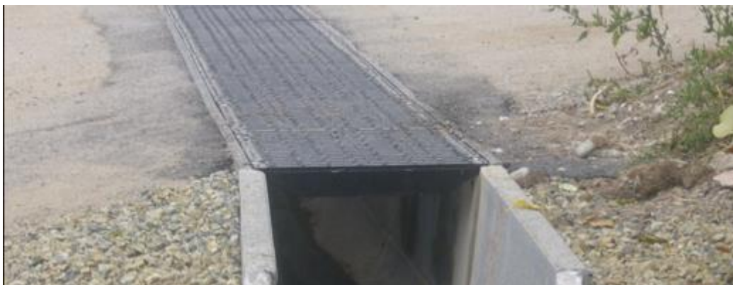
Obrázok 5 Príklad uloženia žľabu / mriežky.
