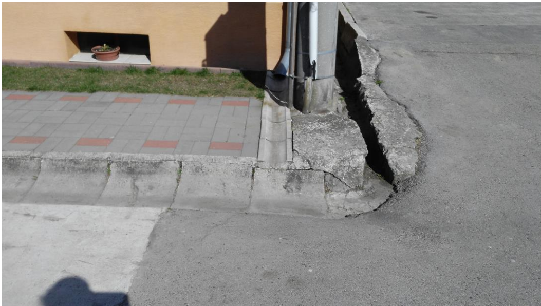
Obrázok 7 Existujúci povrchový žľab - miesto zaústenia novej trasy odvodnenia.
